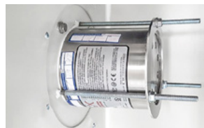
Aerosolgenerator bei der Brandbekämpfung
