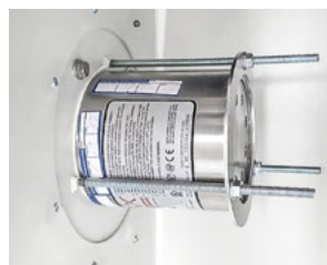
Aerosolgenerator bei der Brandbekämpfung
